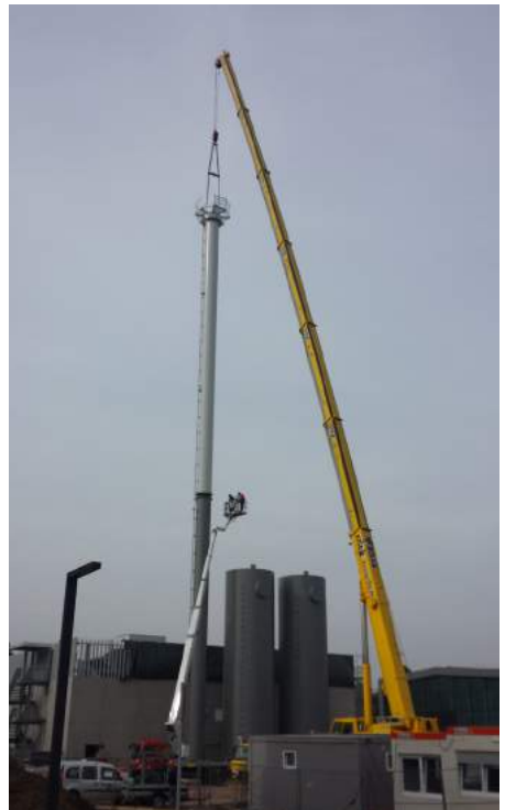
Errichtung des Minarett
