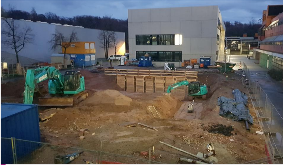
Nächtliche Arbeiten an der neuen U-Bahn-Station Lichtwiese
